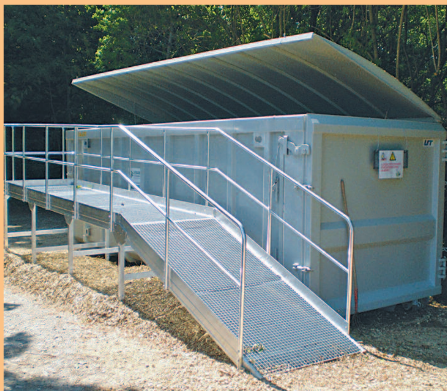
Escalier accès conteneur
