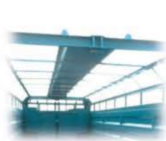
Renfort de toiture
